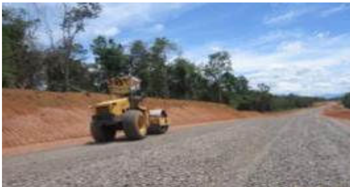
Konstruksi jalan angkutan di Balangan.
